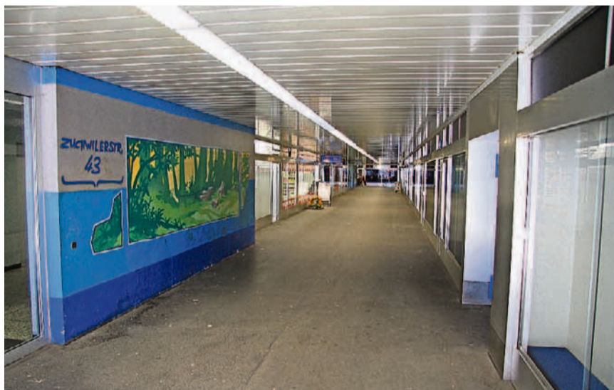
Gibts im südlichen Bereich des Bahnhofs bald mehr Veloplätze? ww
