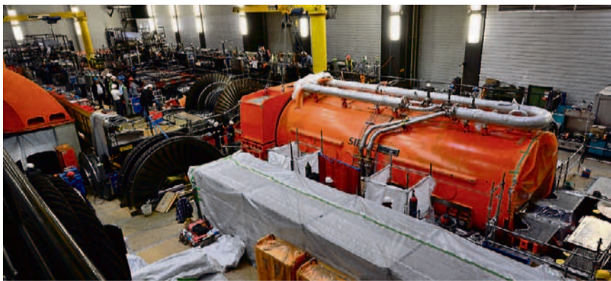
Der neue Siemens-Generator spuckt.
